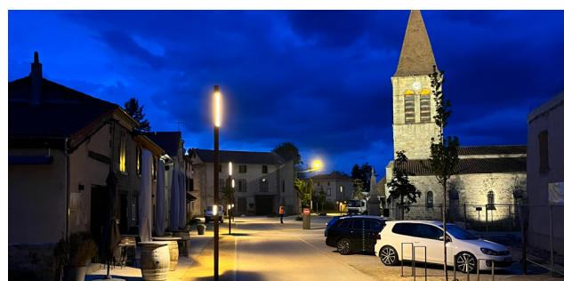
Rénovation LED et mise en valeur de l'église - Orléat
