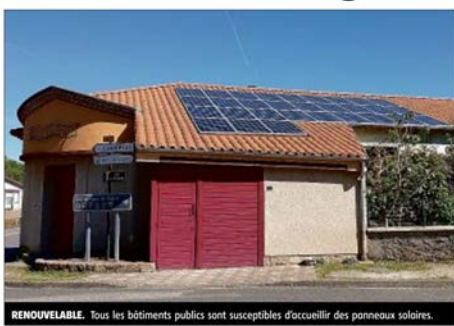
RENOUVELABLE. Tous les bâtiments publics sont susceptibles d'accueillir des panneaux solaires.
