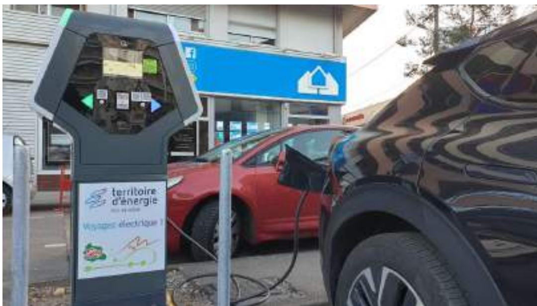
Figure 89 : borne de recharge du réseau aménagé par le TE63
